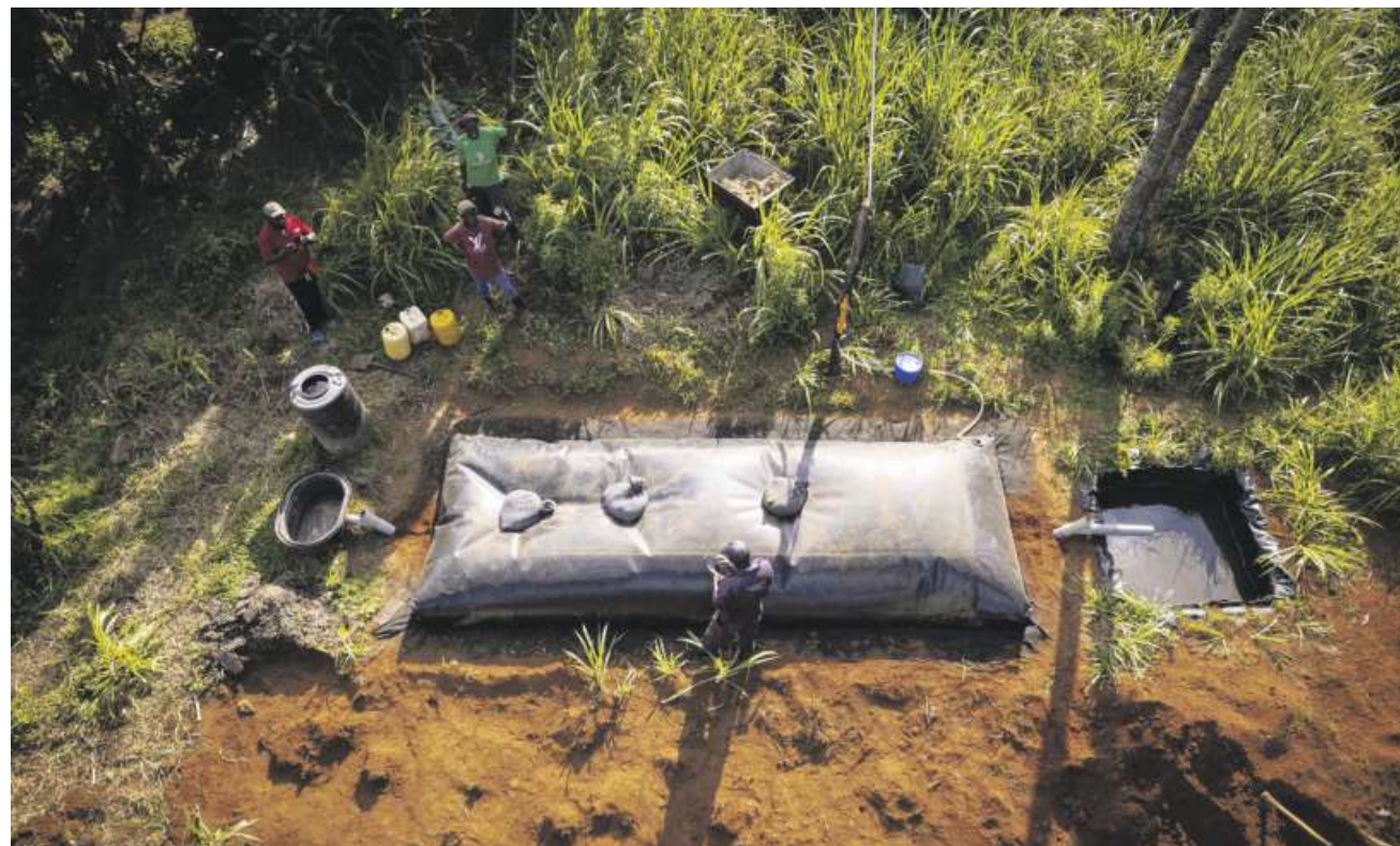
Die Biogasanlagen von Sistema liefern saubere Energie.
