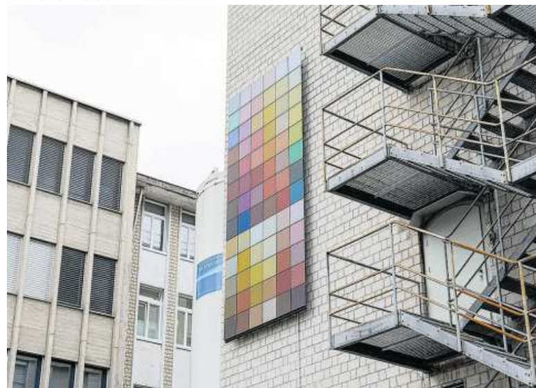
Demowand mit farbigen Photovoltaikmodulen an der Hochschule Luzern.
