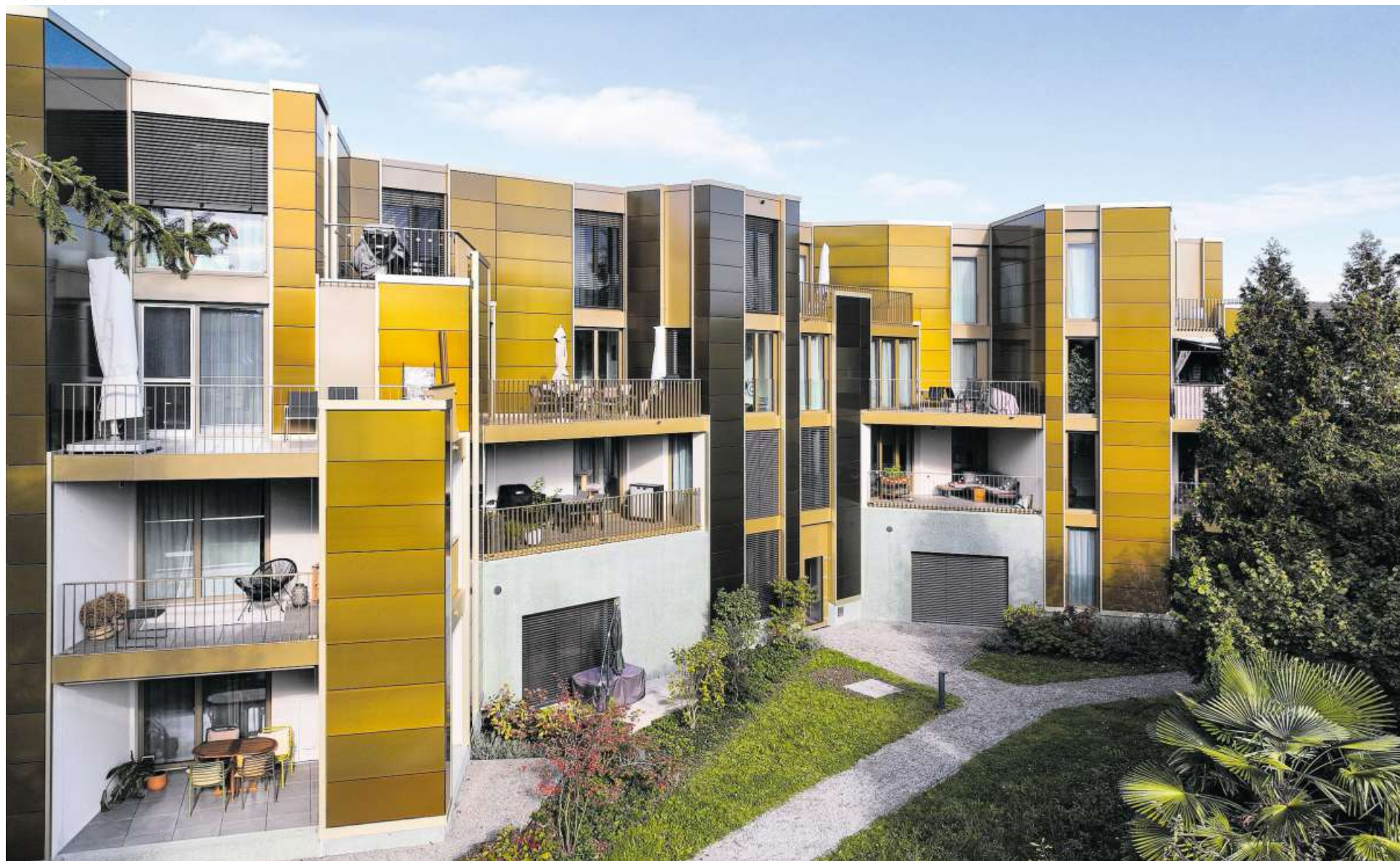
Solarpaneele in einem Goldton an einer Gebäudefassade in Schlieren.
