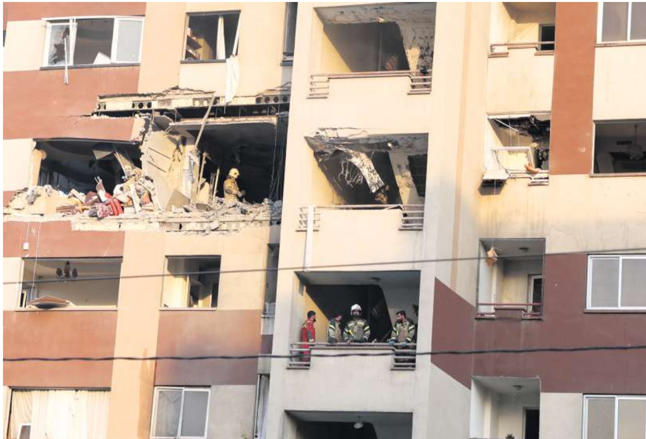
Feuerwehr und Rettungskräfte in einem beschädigten Gebäude in der iranischen Hauptstadt Teheran.
