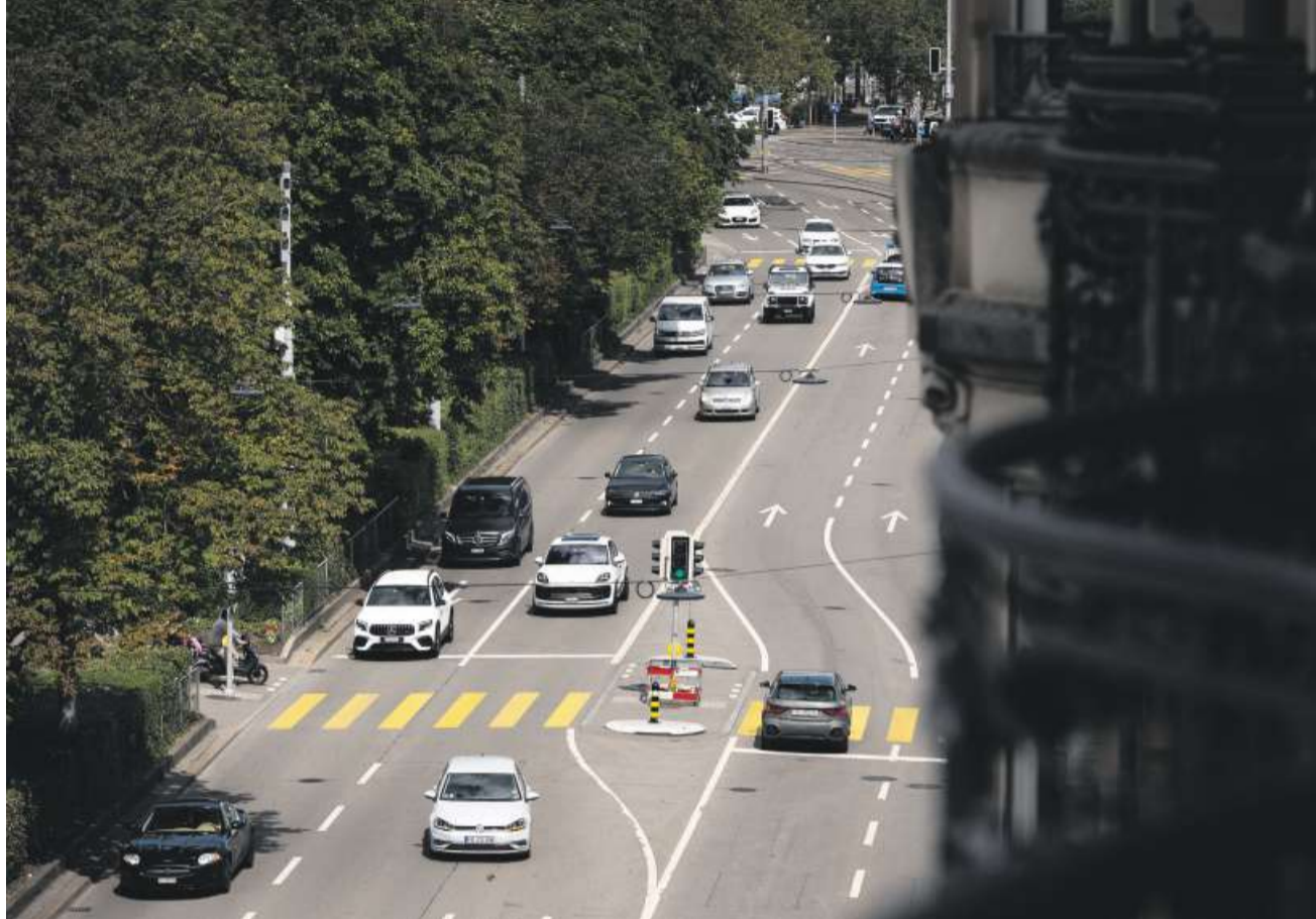
Wegen Reparaturarbeiten nach Wasserrohrbrüchen ist die Bellerivestrasse derzeit nur zweispurig befahrbar.
