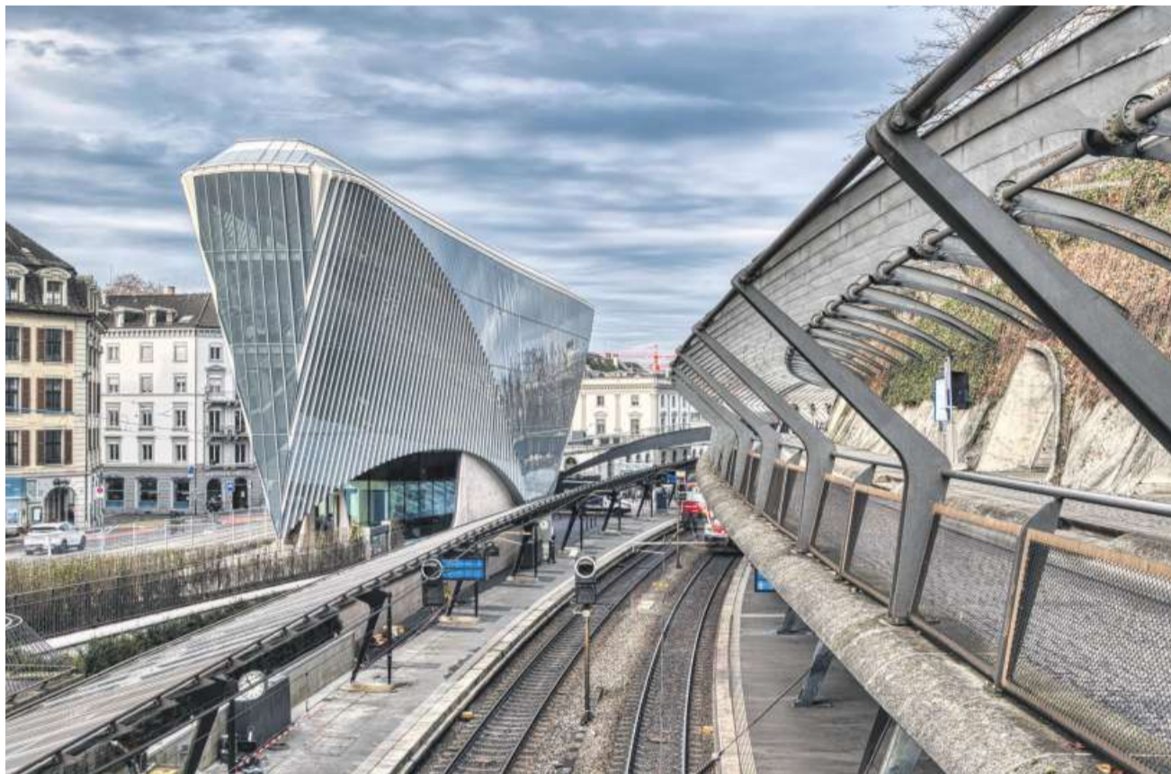
Der Bund will den Bahnhof Zürich Stadelhofen auf vier Geleise ausbauen, doch der Kanton ist unzufrieden.
